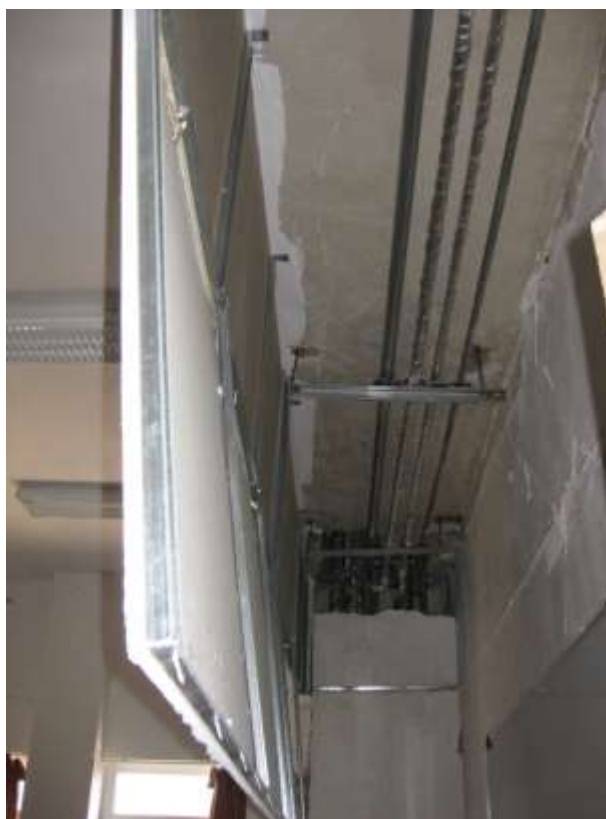
شکل ت ۹-۳- آسیب و سقوط سقف کاذب در ساختمان آموزشی به دلیل عدم کفایت اتصال سقف کاذب به سازه و مهار نامناسب
