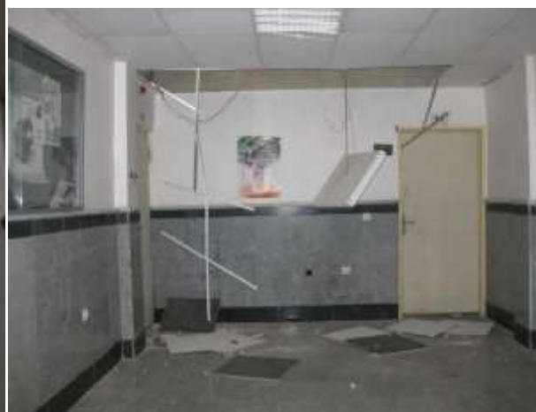
شکل ت ۹-۳- آسیب و سقوط سقف کاذب در ساختمان آموزشی به دلیل عدم کفایت اتصال سقف کاذب به سازه و مهار نامناسب
